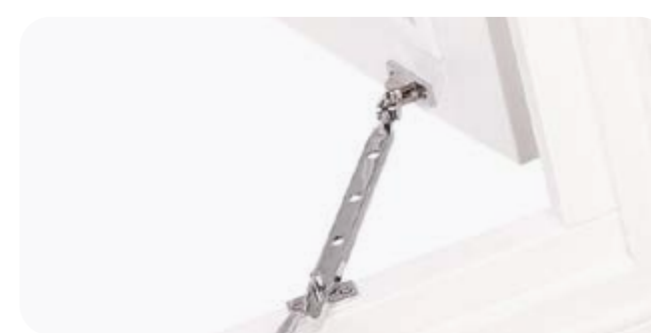
Vleugelramen Vleugelramen kunt u op de gewenste stand openen en vastzetten met de uitzetters.
