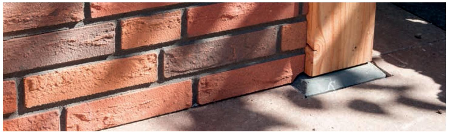
**Alle betonpoeren worden uitgevoerd met vernieuwde verstelbare plaat.**
